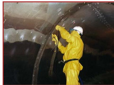
Les fissures et joints de construction dans les structures en béton sont nettoyés avec le 'CRACK FLUSHING AGENT' avant l'injection de résine.
