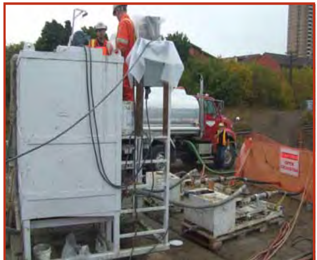
Services publics, coulis cellulaire, Toronto, Ontario Le coulis cellulaire léger est utilisé pour remblayer les tubages après l'installation de conduits délicats et de câbles haute tension sous les voies ferrées, les pistes d'aéroport ou les routes.
