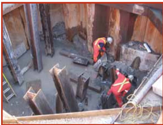
Génie civil lourd, parafouille, Orangeville, Ontario Une combinaison de coulis de ciment et de coulis chimique est utilisée pour couper les grands flux de sol et d'eau dans la construction d'un pont.
