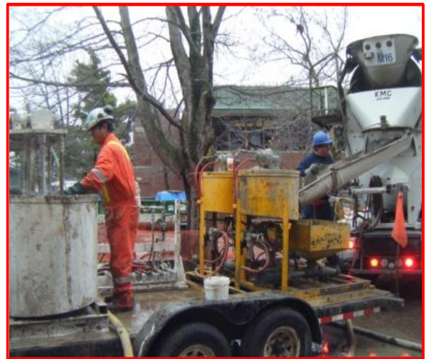
Les entrepreneurs en excavation comptent sur les produits de Multiurethanes, tels que CELBEX 653, pour stabiliser les conditions de sol faibles.
